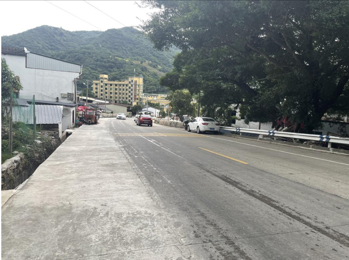
本项目起点接现状国道 G228
