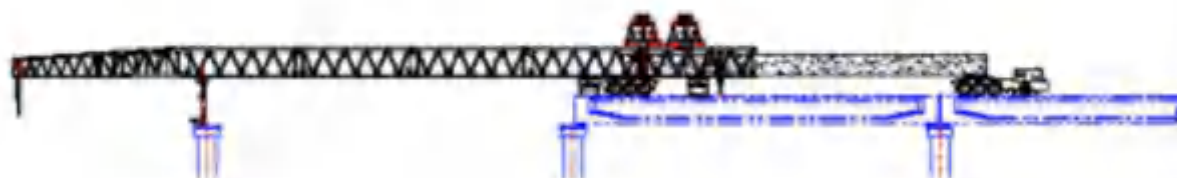
(2) 1#吊重行车配合运梁车送梁
