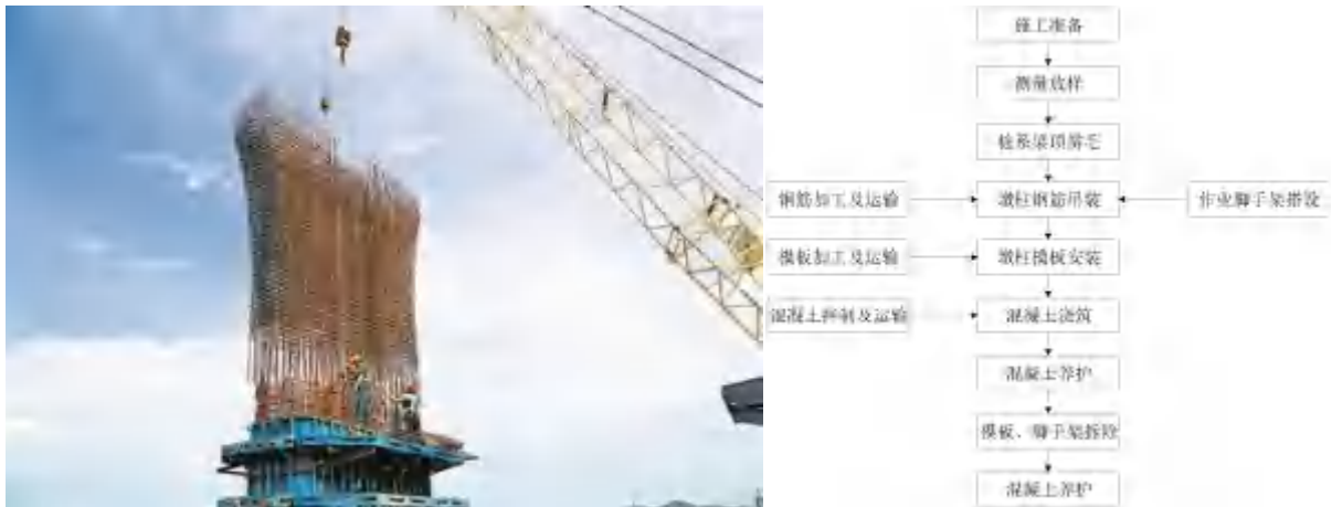
图 3.6-13 墩身结构施工示意图及工艺流程图
